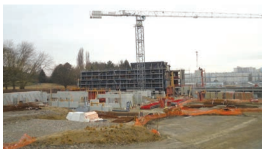
Reconstruction du Collège Bel Air à MULHOUSE
