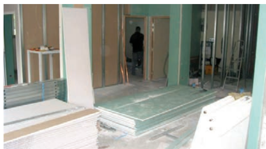
Restructuration du Pôle Gérontologique, rue Gambetta à Colmar
