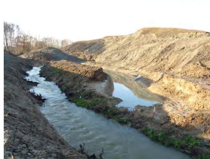
Figure 44 : Rectification du lit mineur* de l'Elbach pour la réalisation du contournement routier de Retzwiller (ancien lit à gauche, nouveau lit à droite)
