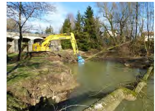
Figure 37 : Enlèvement d'une ancienne vanne d'écluse (à gauche), enlèvement d'embâcle.
