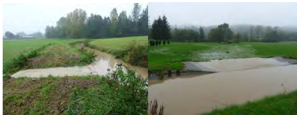
Figure 31 : Déversoir de la rigole en fonctionnement à Strueth (à gauche) et Hindlingen (à droite) lors de la crue d'octobre 2012
