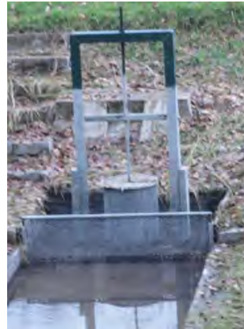
Figure 50 : Vanne de vidange, étang à sec à Seppois-le-Haut. Pêche aux étangs Nérac à Altenach, Saint-Ulrich.
