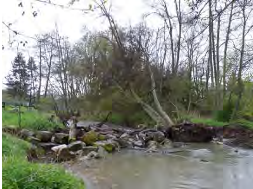
Figure 43 : Seuil* effondré à Seppois-le-Bas, l'abaissement de la ligne d'eau menace la stabilité des ouvrages de génie civil (pont) en amont (à gauche). Stabilisation de la ligne d'eau par la création d'une rampe en enrochement sec franchissable (à droite).
