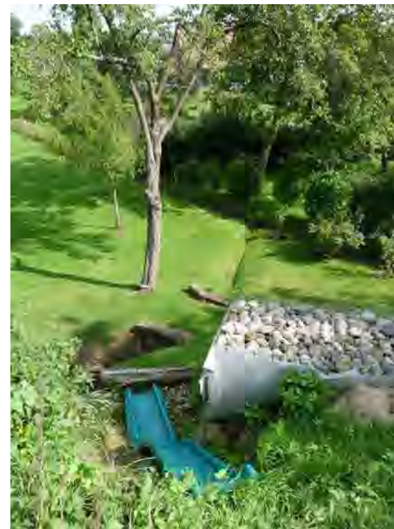
Figure 32 : Exutoire contraint en secteur urbanisé à Saint-Ulrich destiné à recevoir les eaux débordantes de la rigole.
