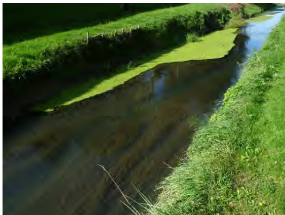
Figure 34 : Eutrophisation et comblement par la végétation aquatique de la rigole d'alimentation du canal du Rhône au Rhin
