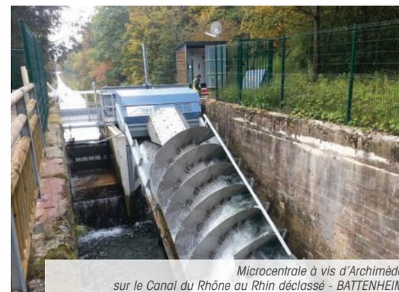
Microcentrale à vis d'Archimède sur le Canal du Rhône au Rhin déclassé - BATTENHEIM
