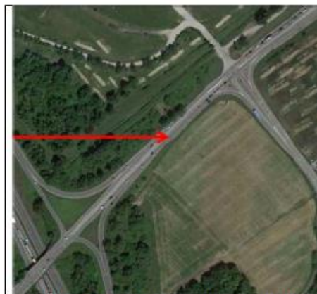
RD105 : Carrefour Est > Gravière (entrée Sud du Technoport)
