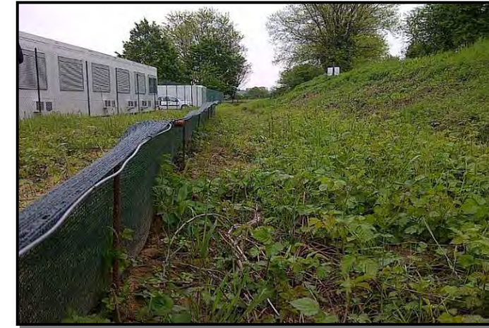
Photographie 46 : Barrière anti-intrusion (source : Egis)
