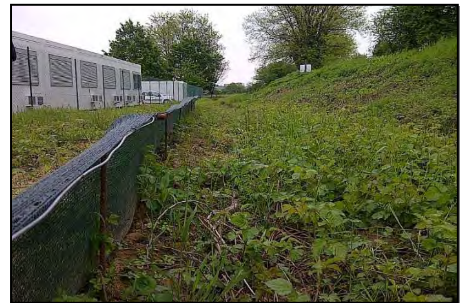
Photographie 31 : Barrière anti-intrusion (source : Egis)
