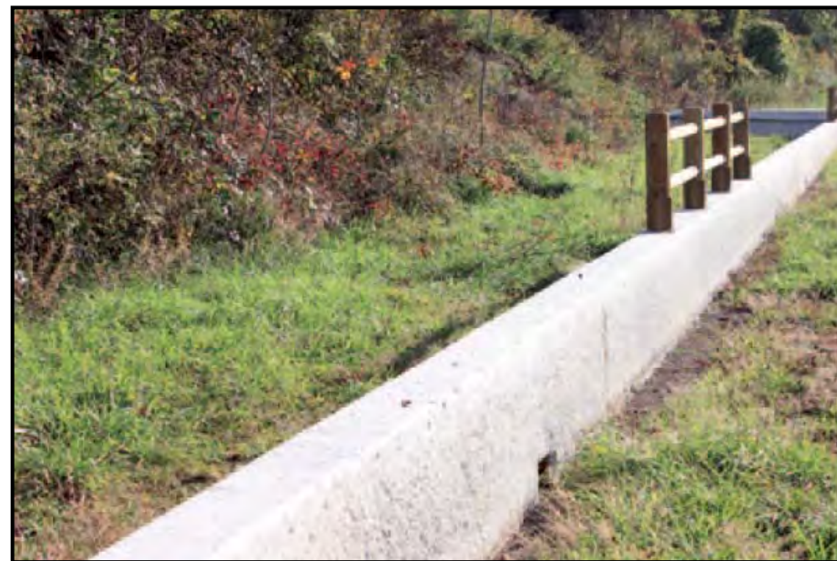
Photographie 50 : Muret béton de protection (source : Egis)
