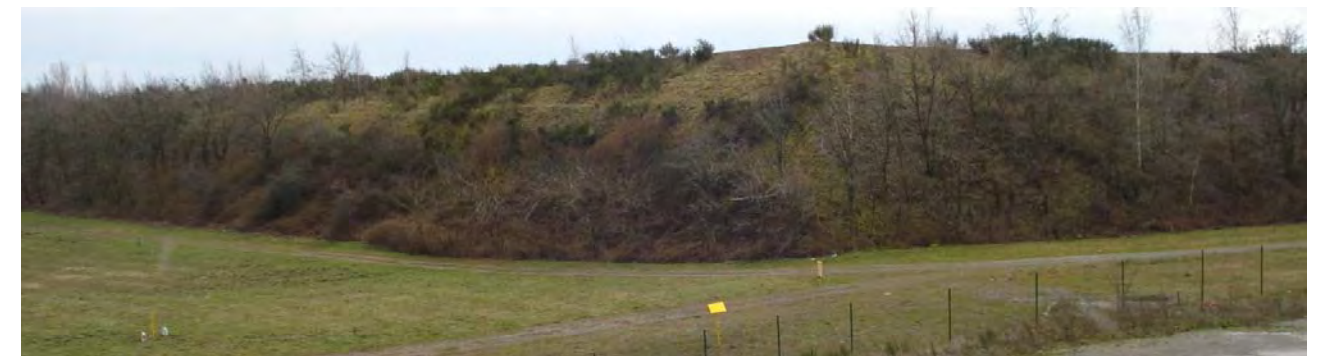
Photographie 26 : Merlons délimitant le teruil de l'Ochsenfeld (source : Egis)
