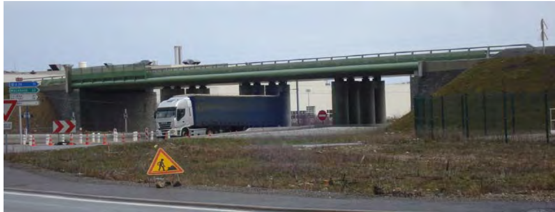
Photographie 31 : RD33 en passage supérieur sur la RN66 (source : Egis)
