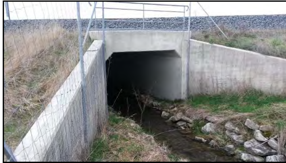
Photographie 51 : Banquette alluviale permettant le déplacement de la faune sous un ouvrage hydraulique (source : Egis)
