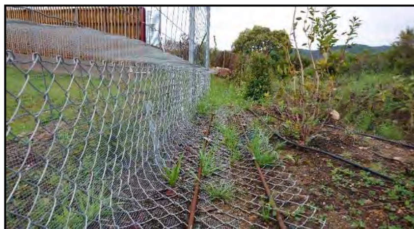
Photographie 32 : Doublement de la clôture (source : Egis)
