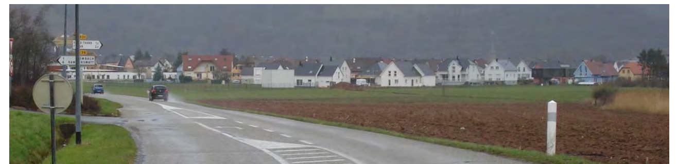
Photographie 7 : Vue sur le lotissement des Tilleuls de Vieux-Thann depuis la RD35 (Leimbach vers Vieux-Thann) (source : Egis)
