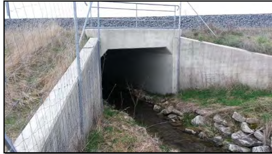
Photographie 35 : Banquette alluviale permettant le déplacement de la faune sous un ouvrage hydraulique (source : Egis)
