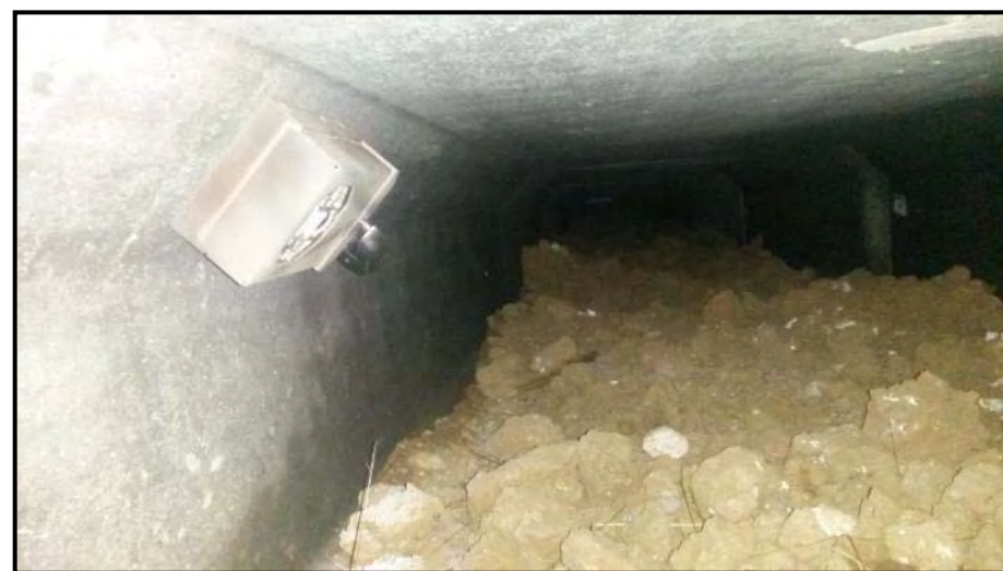
Photographie 37 : Dispositif de suivi de la petite faune (source : Egis)
