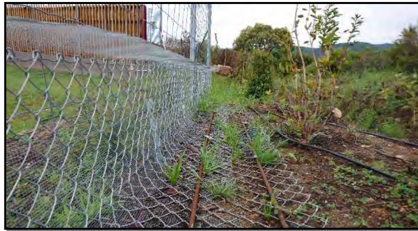
Photographie 47 : Doublement de la clôture (source : Egis)
