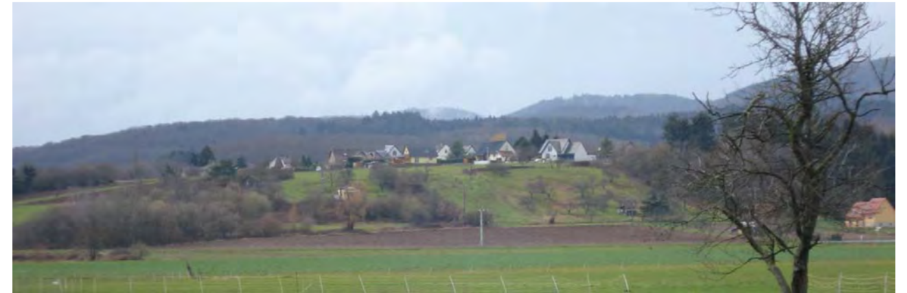
Photographie 25 : Relief de type collinéen au Sud-Ouest de l'aire d'étude (source : Egis)
