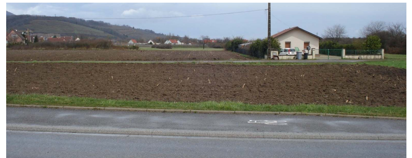
Photographie 3 : Habitation isolée située à proximité de la RD103 (source : Egis)
