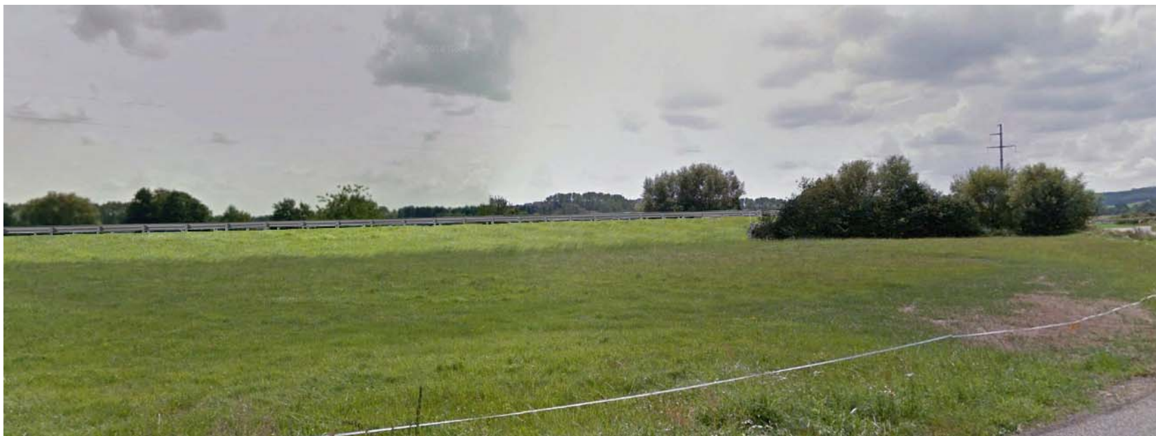
Vue de l'ouvrage depuis l'ancienne route RD35 (après recolonisation de la végétation)
