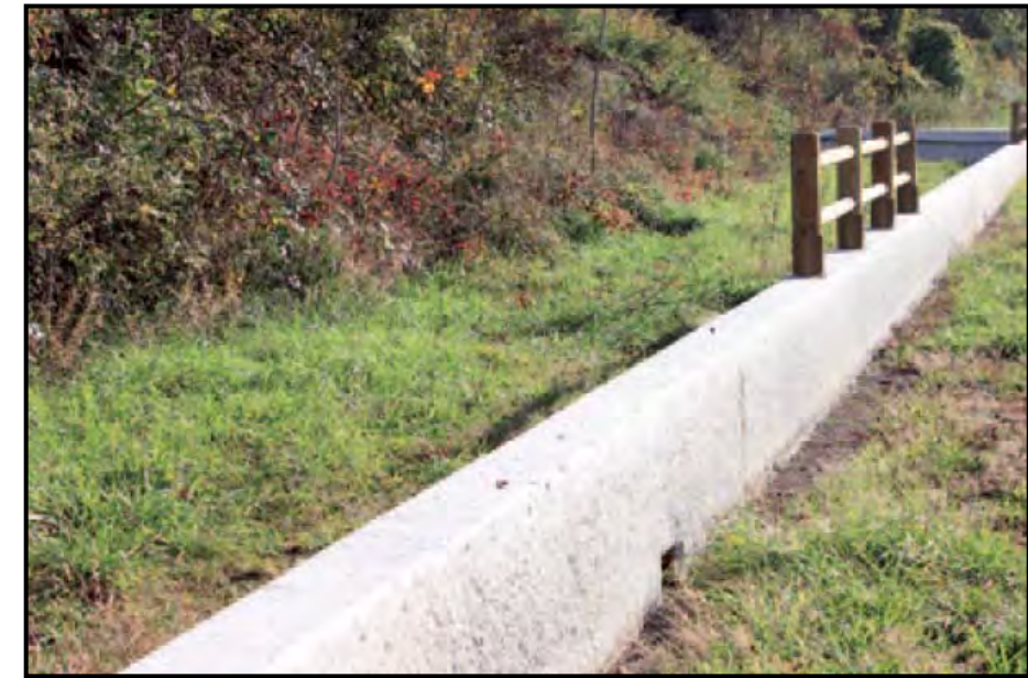
Photographie 34 : Muret béton de protection (source : Egis)
