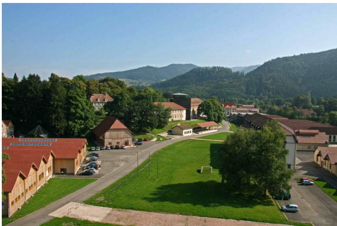
Parc de Wesserling, 2017, de gauche à droite : Pavillon des créateurs, Hall des producteurs, Habitations, Musée, Grande-Chaufferie, hôtel d'entreprises, ateliers des artistes © Parc de Wesserling
