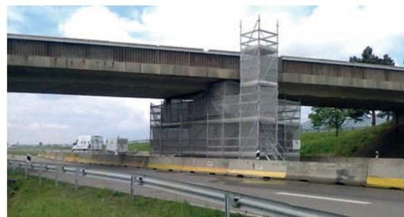
L'opération consistait à reprendre, avec du béton projeté, la pile centrale du pont fortement dégradée par les effets du sel de déverglaçage. La réfection de l'étanchéité et des abouts des deux dalles du pont a également été effectuée. Pour permettre ces travaux, les tabliers ont été soulevés de plus d'un mètre de hauteur à l'aide de vérins.
