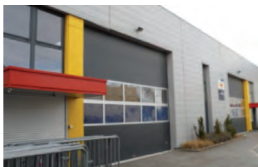
Locaux loués pour les ateliers départementaux, rue du prunier à COLMAR
