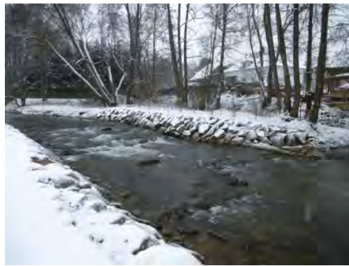
Figure 43 : Seuil* effondré à Seppois-le-Bas, l'abaissement de la ligne d'eau menace la stabilité des ouvrages de génie civil (pont) en amont (à gauche). Stabilisation de la ligne d'eau par la création d'une rampe en enrochement sec franchissable (à droite).
