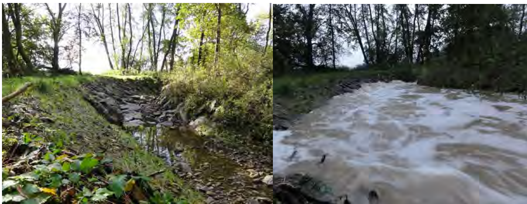
Figure 29 : Déversoir de crue sur la Largue à Dannemarie à sec hors période de crue (à gauche) et en période de crue (à droite).
