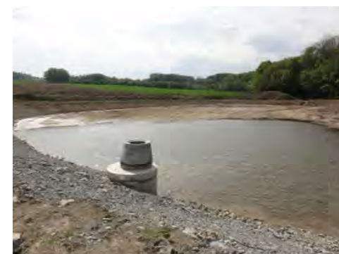
Figure 49 : Prise d'eau d'étang à Soppe-le-Haut, Terrassement d'un chapelet étang à Ueberstrass (2001), Vidange et réfection d'un étang à Guevenatten (2013).
