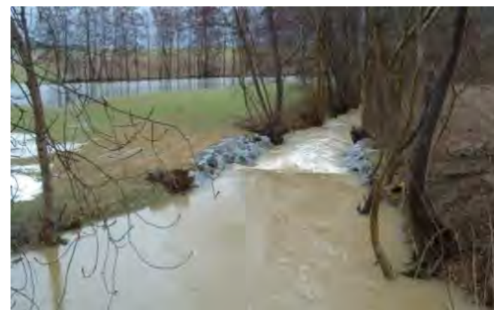
Figure 24 : Seuil* à contraction sur le Soultzbach à Falkwiller, noyé pendant la crue puis après la crue
