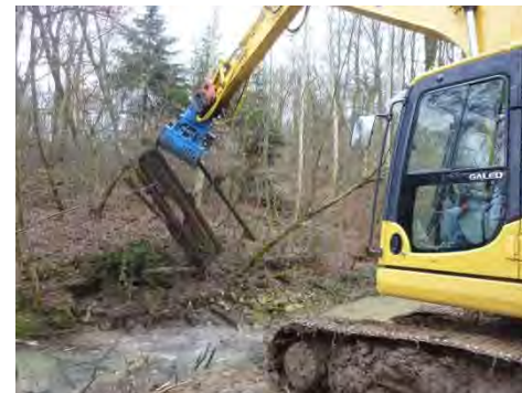
Figure 37 : Enlèvement d'une ancienne vanne d'écluse (à gauche), enlèvement d'embâcle.
