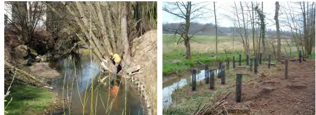
Figure 36 : Coupe d'allégement d'une cépée de saules déstabilisée (à gauche). Plantations après enlèvement de résineux sur la Gruebaine (à droite)
