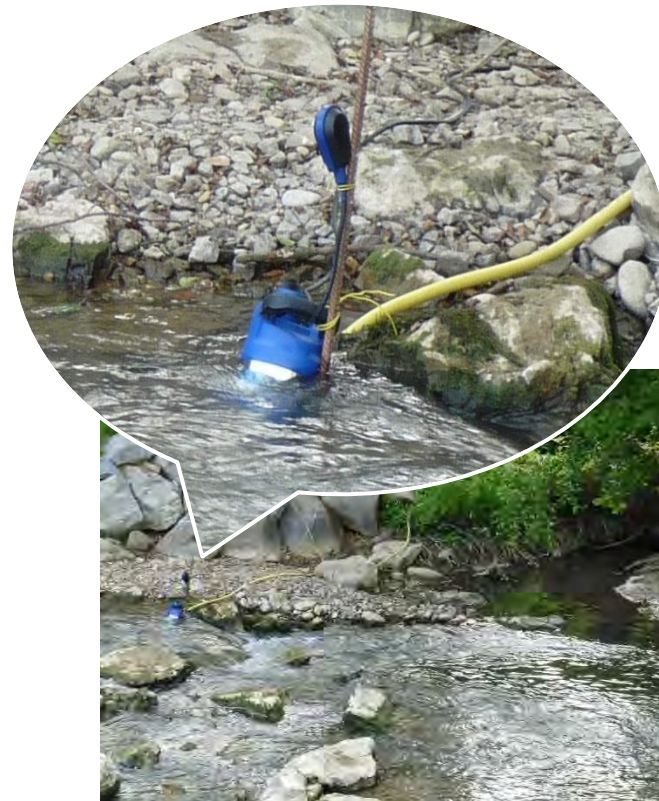
Figure 16 : Installation de pompage individuelle temporaire dans la Largue.
