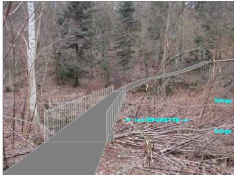
PASSERELLE ALUMINIUM AU DROIT DE LA LIEPVRETTE
