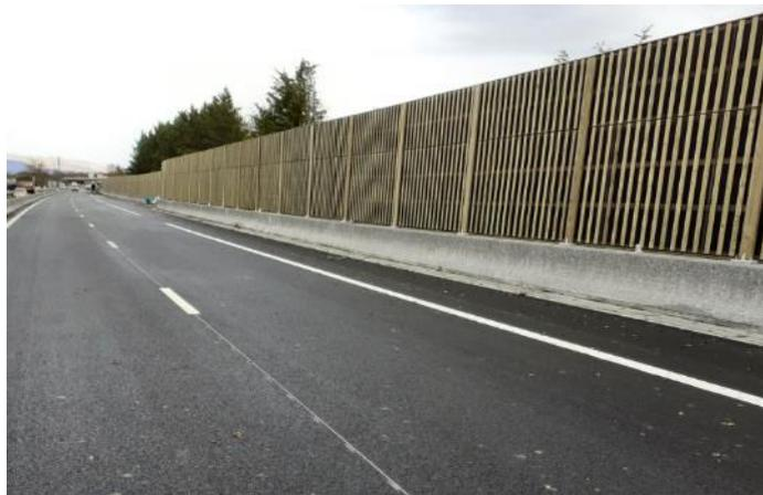
Photo 9: Réalisation du mur anti-bruit : mutualisation des fondations avec le dispositif de retenue ; choix de matériaux bois
