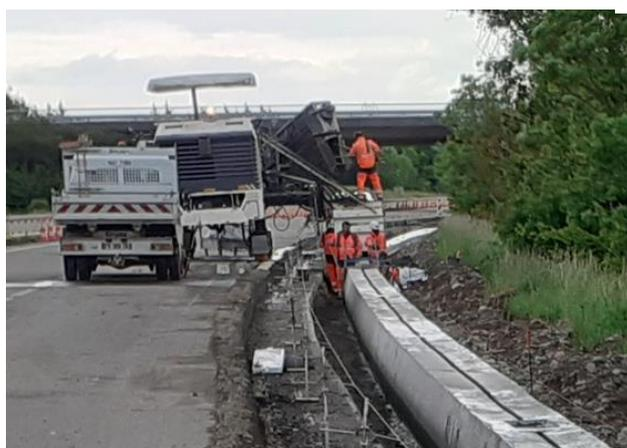
*Photo 7: En matière de protection de l'environnement, les travaux ont porté sur la réalisation de plus de 3 000 mètres de caniveaux à fente*
