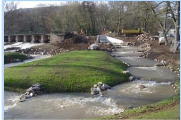
Photo 12 : Franchissement piscicole du barrage d'Avolsheim sur la Bruche par une rivière de contournement artificielle.
