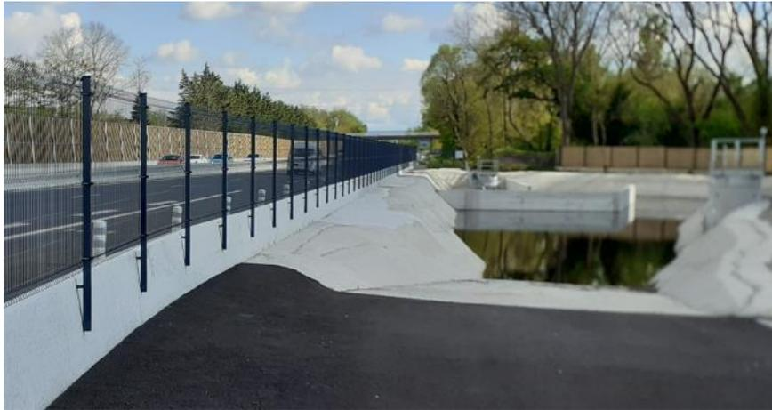
Photo 8: Réalisation d'un bassin de traitement des eaux pluviales de 1 300 m<sup>3</sup>
