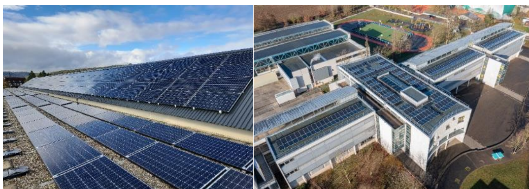
Installation Panneaux Photovoltaïques à Wissembourg et à Truchtersheim
