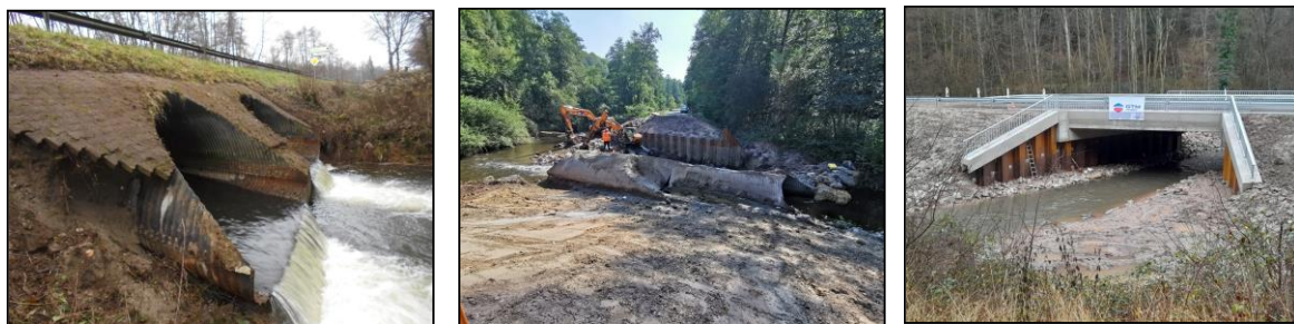
Travaux d'effacement des buses et reconstruction d'un pont à WOERTH
