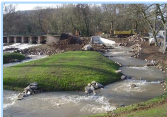
Photo 9 : Franchissement piscicole du barrage d'Avolsheim sur la Bruche par une rivière de contournement artificielle.
