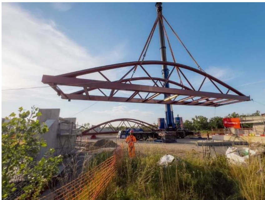
5A3F - Pose de la passerelle piétons – cyclistes (juillet 2025). ©CeA
