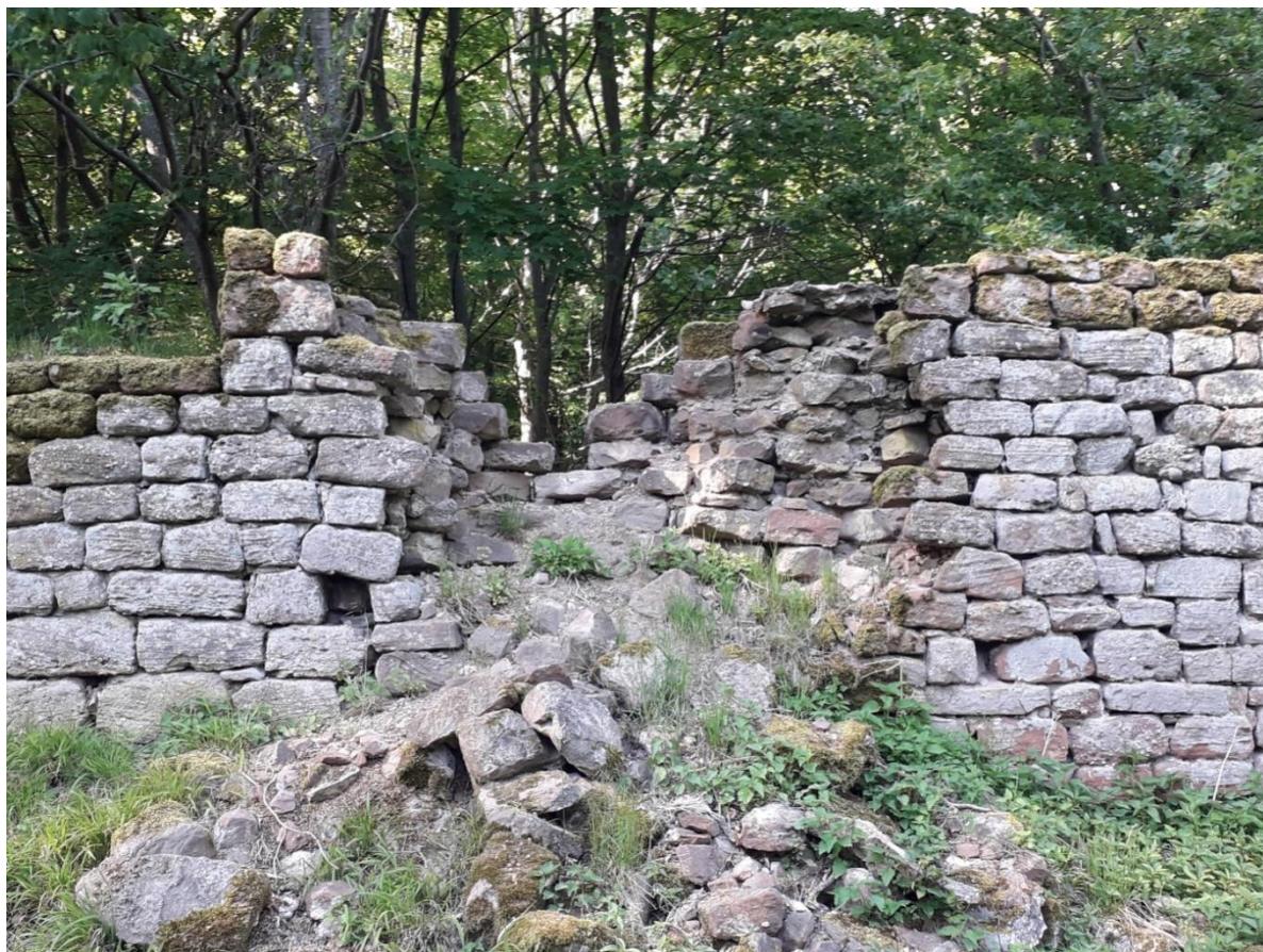
Ochsenstein ; la brèche, qui n'était qu'un simple ventre en 2000, s'est ouverte très rapidement, par manque d'entretien
