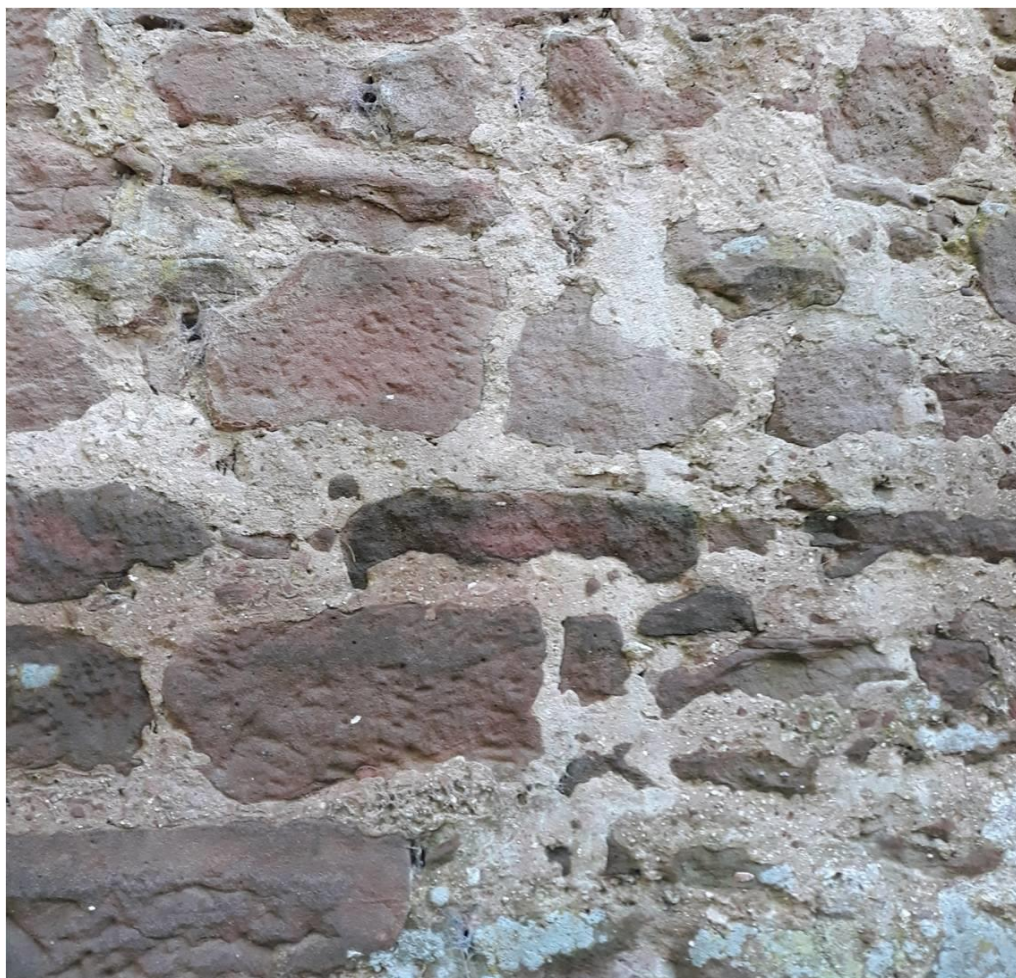
Appareil de moellons de grès, avec nombreuses calles de grès noyées dans les reliquats d'enduit (Wineck)
