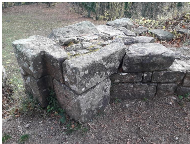
Landsberg : autre porte, après dépose et reposé des blocs d'embrasement, et rocaillage façon ruine, joints creux
