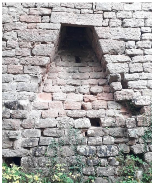
Dreistein oriental : deux blocs de la hotte de cheminée sont tombés récemment. Sans leur restitution, la hotte est menacée de ruine
