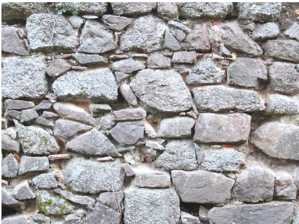
Appareil mixte avec joints de natures diverses ; tuile, schiste, granite (Andlau)
