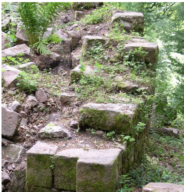
Salm : stabilisation par dépose-repose à l'identique de l'arase du mur, sans aucun complément de parement
