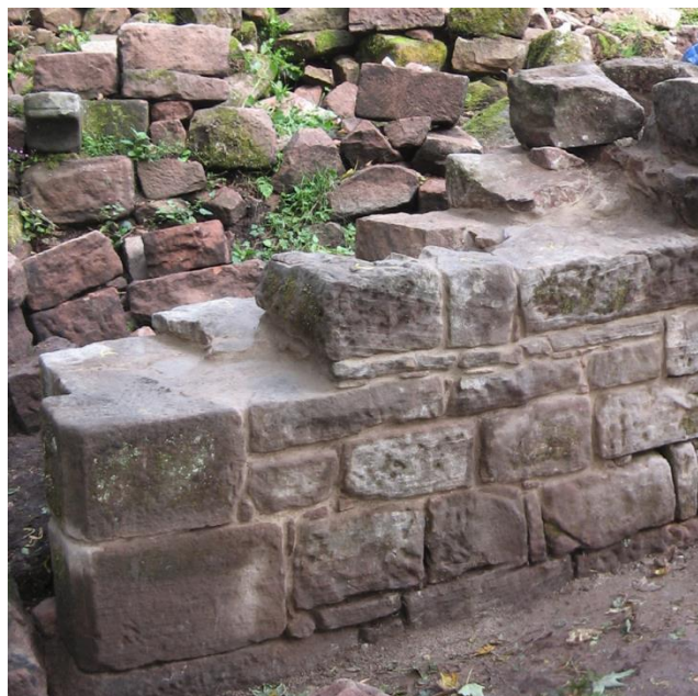
Salm : stabilisation par dépose-repose à l'identique de l'arase du mur, sans aucun complément de parement
