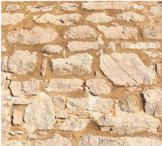
Exemple de rejointoiement à « pierre vue », laissant apparaître les calles d'origine, y compris les plus petites
