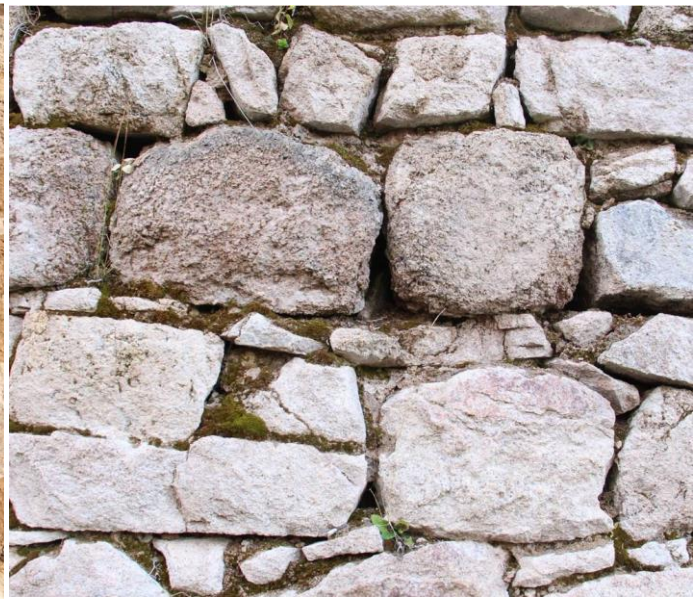
Exemple de mur en appareil mixte employant des calles de formats variés, avec joints dégradés entraînant à terme la perte de calles
