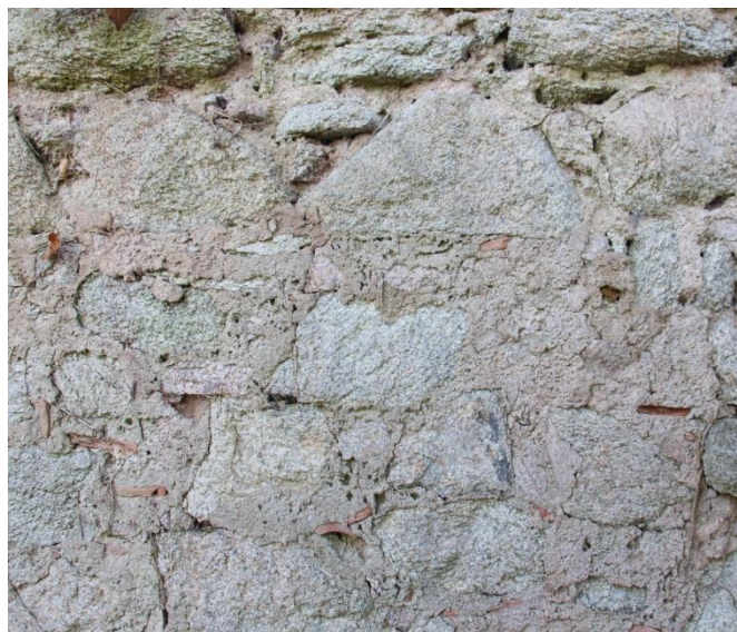
Autre partie du même mur, non dégradée
