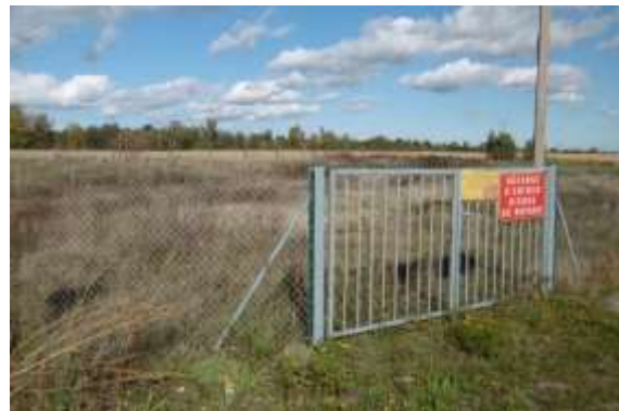
Exemple de bassin de traitement des eaux pluviales (surveillance et entretien) - contournement de Wittelsheim
