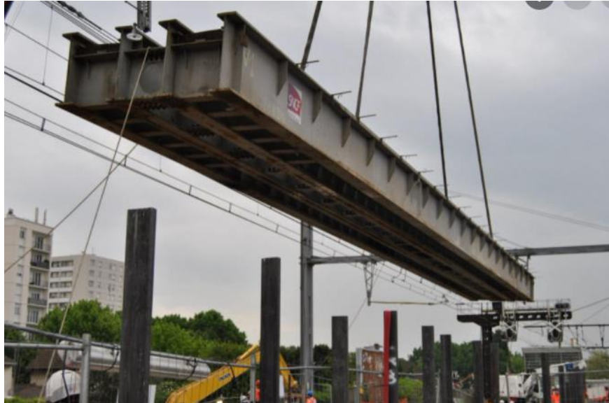
Mise en place à la grue d'un tablier auxiliaire
