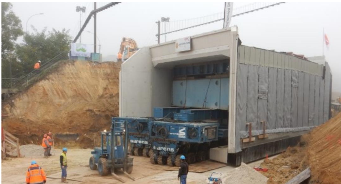
Ripage d'un portique à l'aide de chariots automoteurs avec câbles sur tancarville (partie haute)
