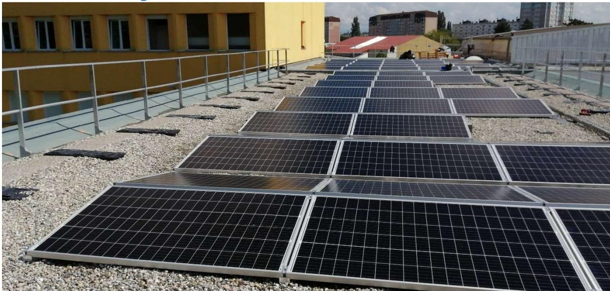
Puissance installée 98,34 KWc, soit 298 panneaux (503 m<sup>2</sup>), pour un coût total travaux de 211 852 € HT
