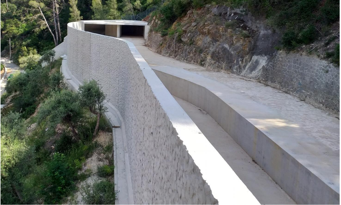
Figure 23 - Exemples de parement en béton matricé du coursier d'un évacuateur de crues
