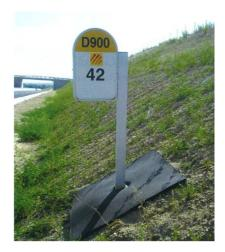
3- Poser la signalisation sur supports fusibles, éviter ainsi les dispositifs de retenue et ne pas se retrouver avec du fauchage à faire sous ces derniers (voir point 1)
