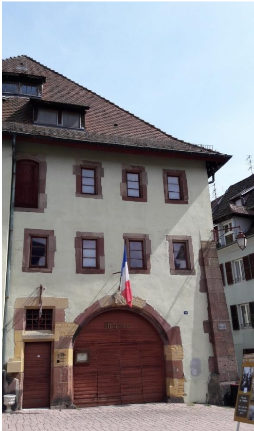
Ancienne Halle aux Blés – façade rue Saint Thiébaud
