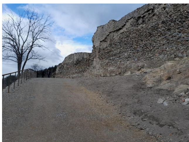
Remparts Sud – suite restauration en 3 tranches 1997 – 2023
