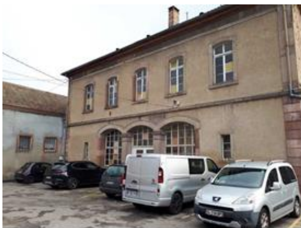
VUE DE L'ANCIENNE ECOLE DES GARÇONS COTE COUR DE LA MAIRIE (PARKING)
