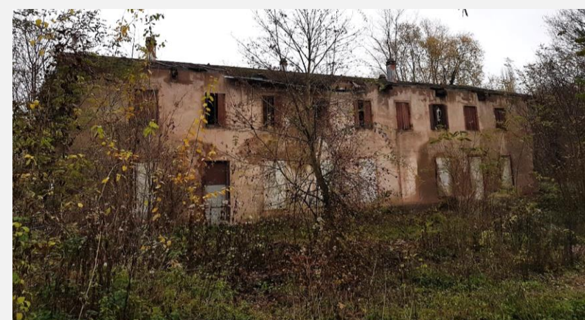
Schlosmatten : Commune et Foyer Basse Bruche
