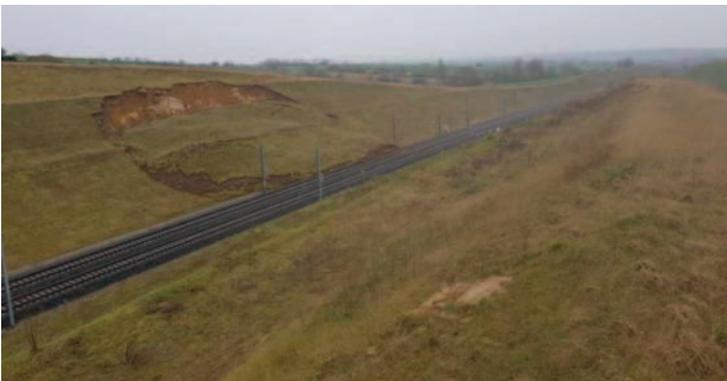
Déraillement d'un TGV dans le secteur d'Ingenheim provoqué par un glissement de terrain en 2020.
