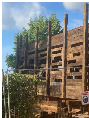
Photos de la structure en bois de charpente de réemploi
