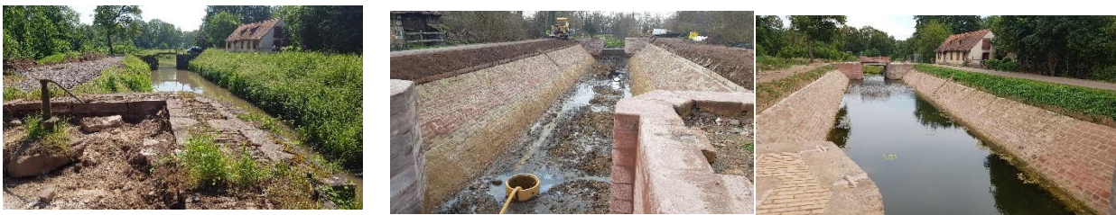
Restauration de l'écluse n°5 à KOLBSHEIM (avant – pendant – après travaux).
