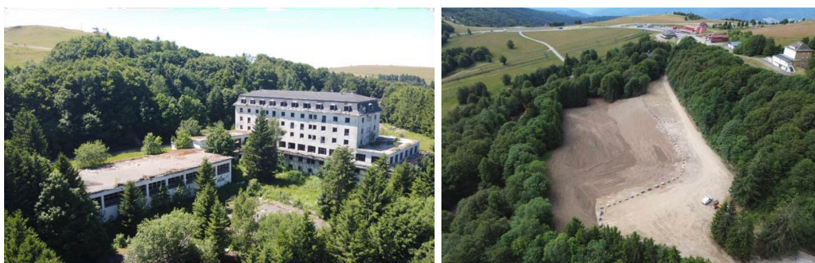
Le site Touristra – avant et après travaux de démolition.
