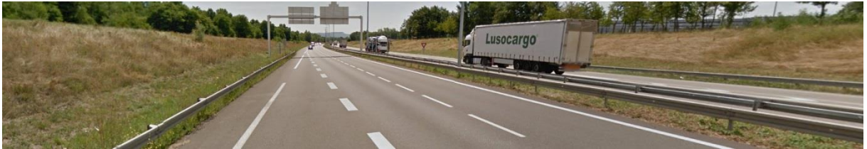
Fig.18 Fossés enherbés de part et d'autre de l'A35
