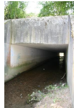
Fig. 13. Ouvrage hydraulique du Liesbach sous l'autoroute
