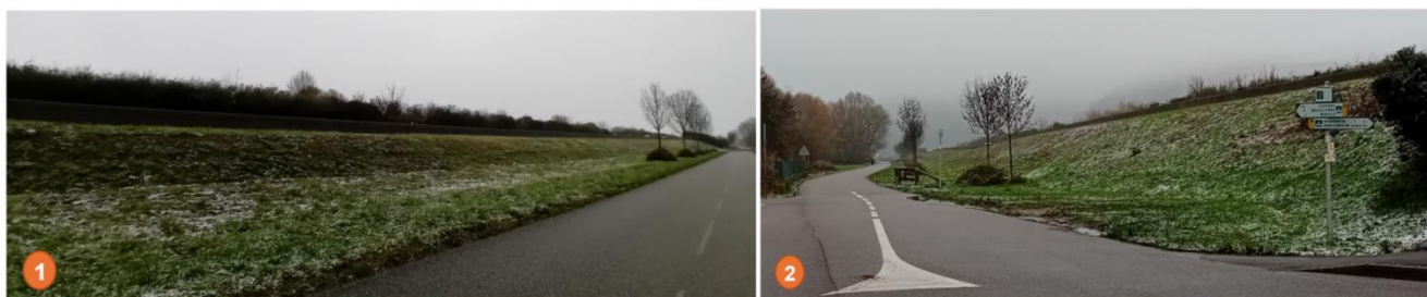
Figure 3 - Photos de face du talus
