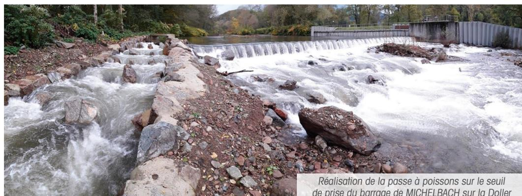
Réalisation de la passe à poissons sur le seuil de prise du barrage de MICHELBACH sur la Doller
