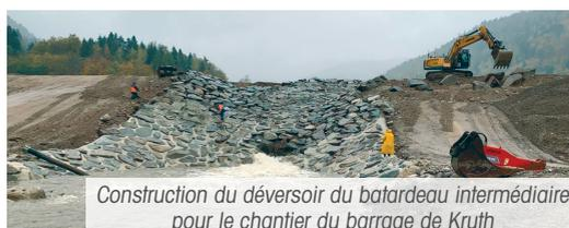
Construction du déversoir du batardeau intermédiaire pour le chantier du barrage de Kruth
