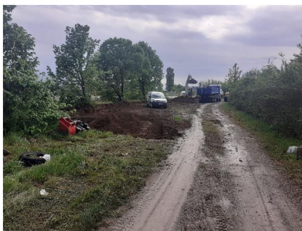
Terrassement - Décapage de la terre végétale.
