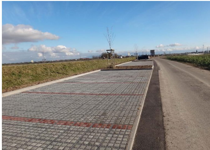
Des dalles drainantes réduisent l'impact écologique de l'aménagement.
