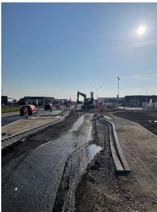
Les îlots séparateurs sont achevés.
