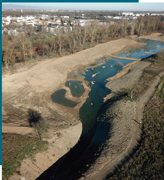
Un chantier de renaturation à Mulhouse. RHA y intervient dans la conception et la réalisation (© RHA).
