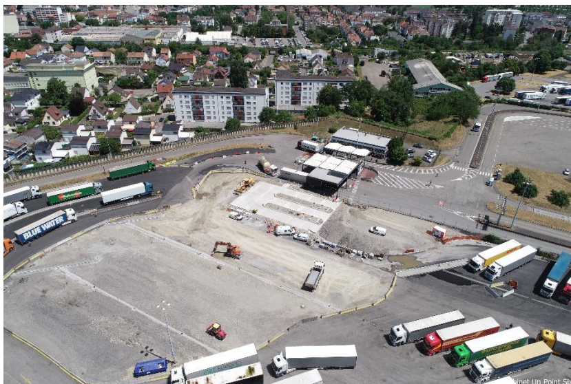
Vue aérienne des travaux de la plateforme douanière de Saint-Louis.
