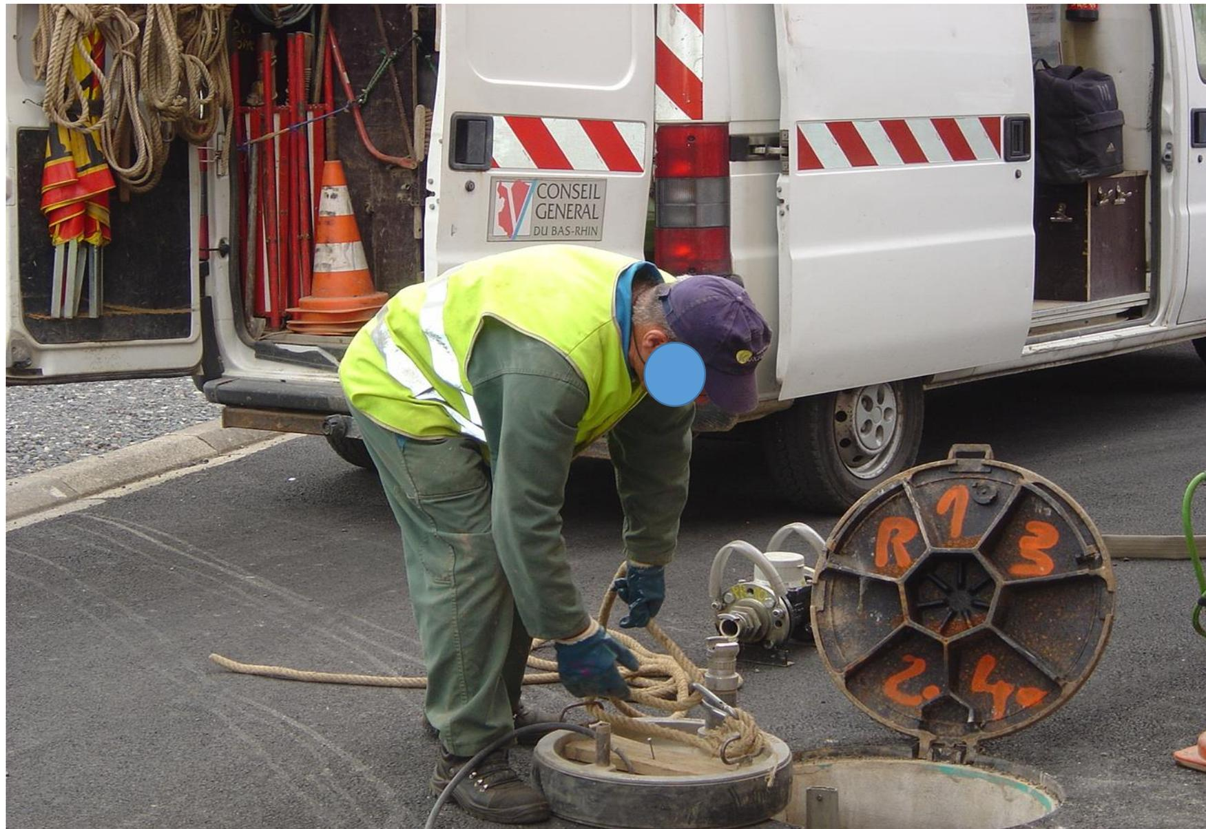
Manipulation d'un obturateur pour la réalisation d'un test d'étanchéité sur un collecteur d'assainissement
