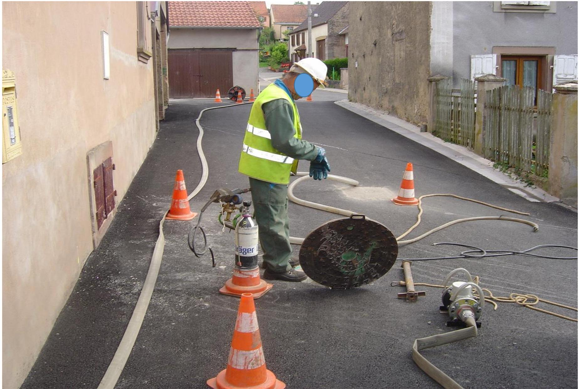
Réalisation d'essai d'étanchéité à l'eau sur un collecteur enterré
