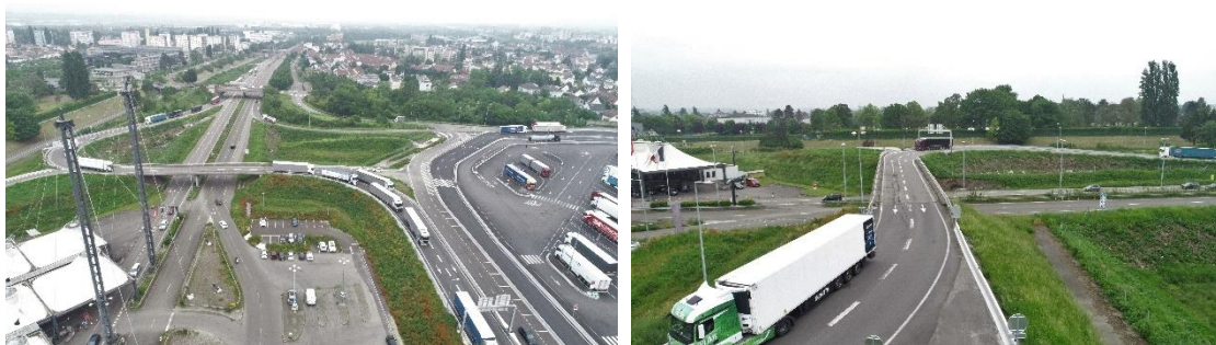
Pont qui enjambe l'A35 et accès à la plateforme douanière.
