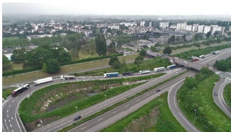
Bretelle d'accès à la plateforme douanière.
