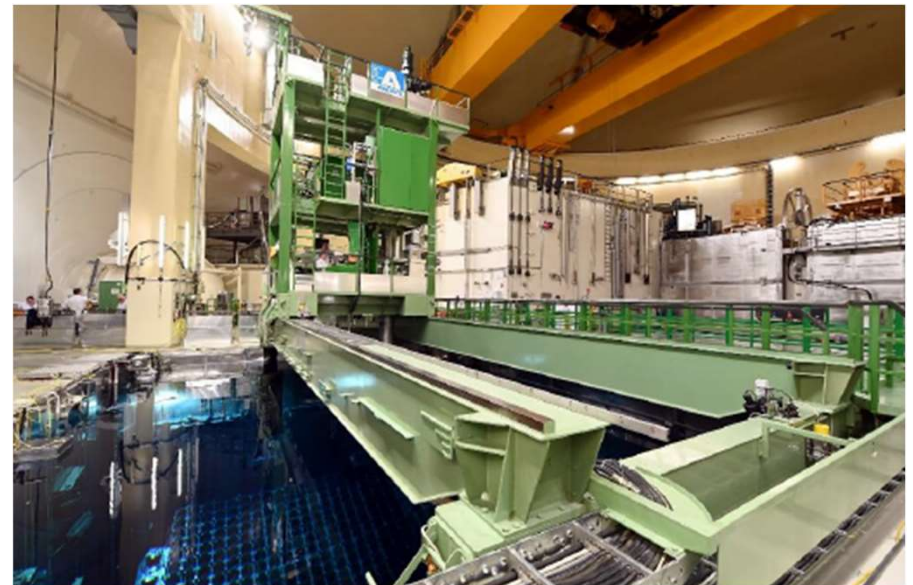
BE /Bassin de stockage KKP 2
