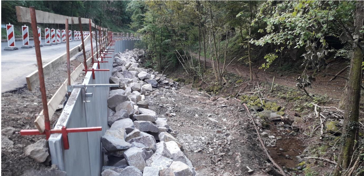
Enrochement du mur.
