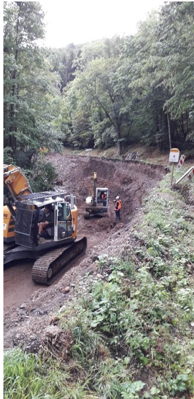
Les pelles ont creusé jusqu'à 7 mètres de profondeur.
