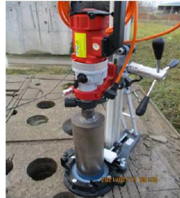
Prélèvement par carottage (chantier école en extérieur)
