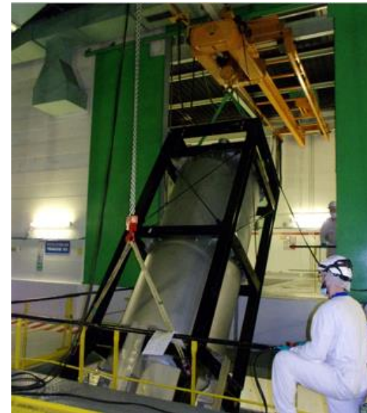
Installation des nouveaux réservoirs
