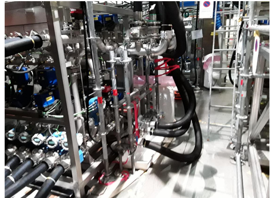
Introduction et connexion des skids de décontamination
