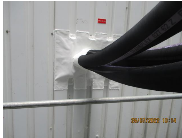
Création de nouvelles trémies et rebouchages coupe-feu
