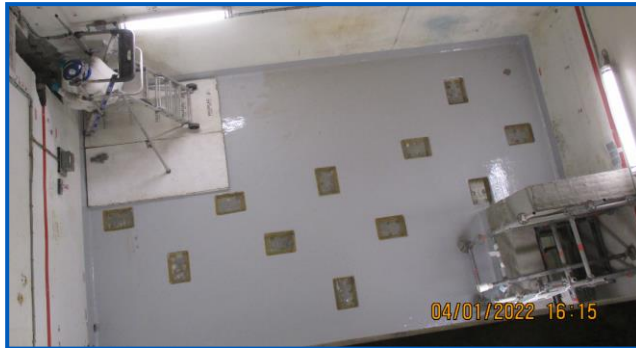
Création d'une rétention en béton revêtu
