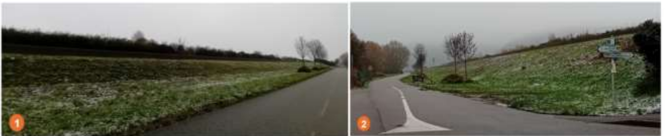
Figure 3 - Photos de face du talus
