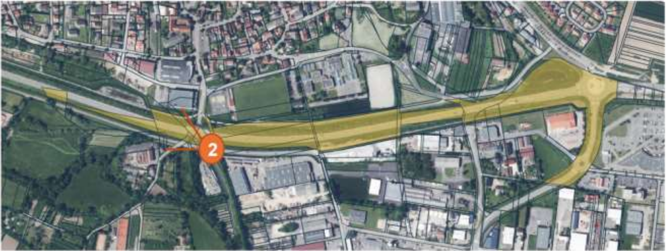
Figure 2 - Vue satellite cadastrale du talus section Est
