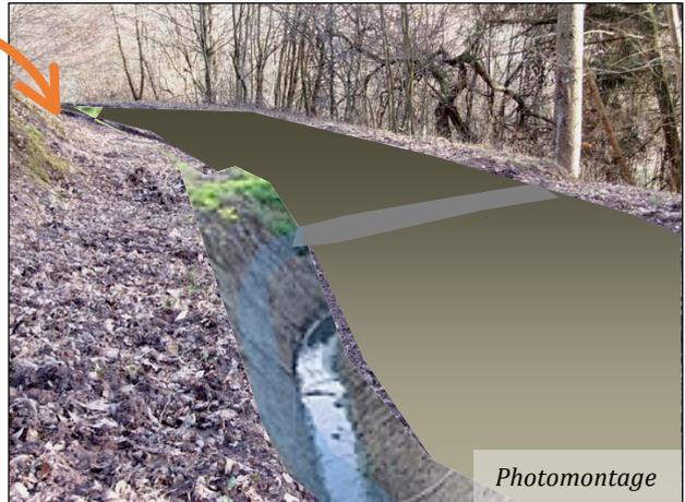
*Opération n°5d : amélioration du chemin par rechargement, curage du fossé d'accotement à gauche, et pose d'une buse pour la traversée du chemin en remplacement du passage d'eau raviné.*
