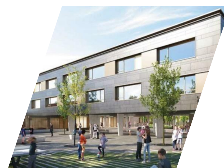
Restructuration du collège d'Hegenheim : 10,6 M€
