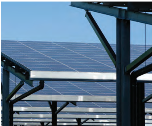
Aire de covoiturage à Châtenois au croisement des RD1059/RD559 : parking de 158 places recouvert sur sa totalité de 1 401 panneaux photovoltaïques pour une puissance installée électrique de 697 kWc. L'ensemble du projet est ceinturé d'une diversité d'arbres créant ainsi une canopée photovoltaïque.
