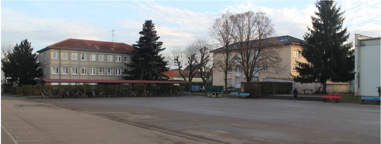
Cour / abri-cycles / espaces extérieurs
