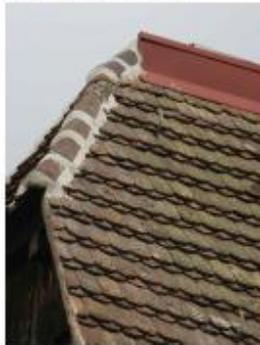
Tuiles queue de castor d'origine avec pose couronnée des versants intérieurs du Bastion de l'étoile
