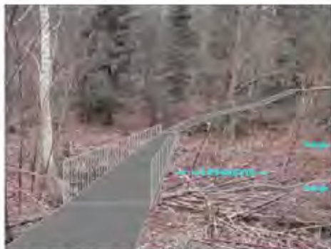
PASSERELLE ALUMINIUM AU DROIT DE LA LIEPVRETTE
