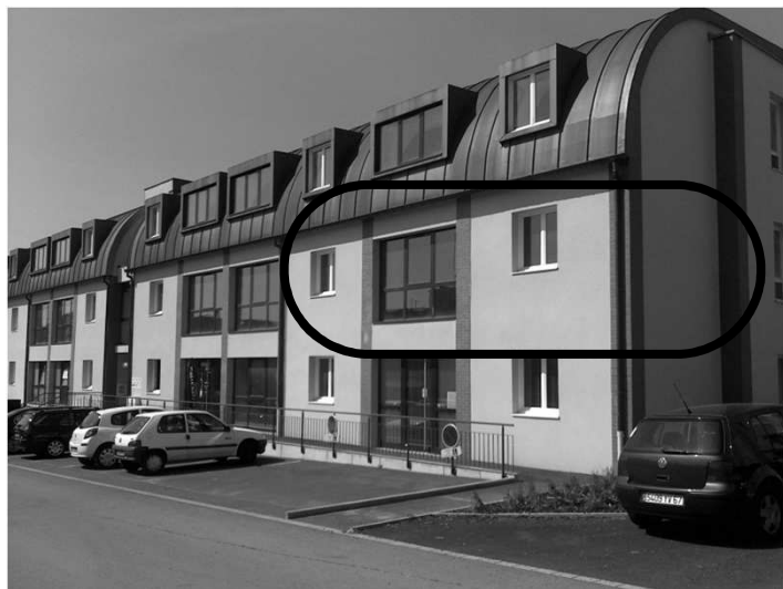
Photo 1 : Vue depuis la rue Antoine Wagner Façade Est
