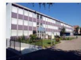
Bâtiment C – Façade Est
