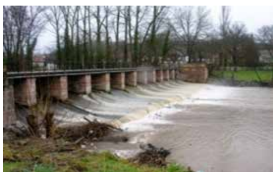
Restauration/valorisation Canal de la Bruche
