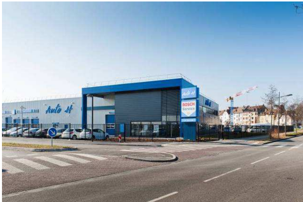
Installation d'entreprise à l'entrée Nord
