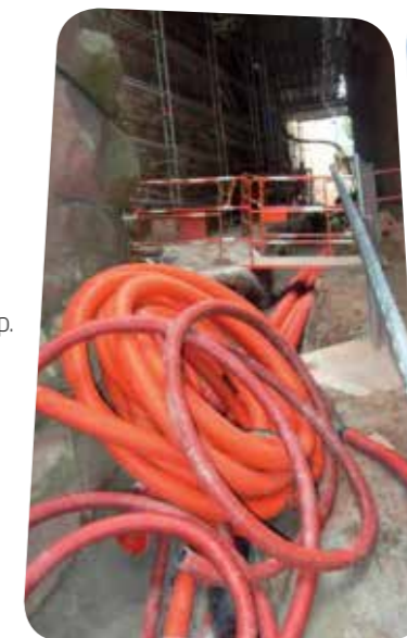
Lice sud : passage de réseaux
