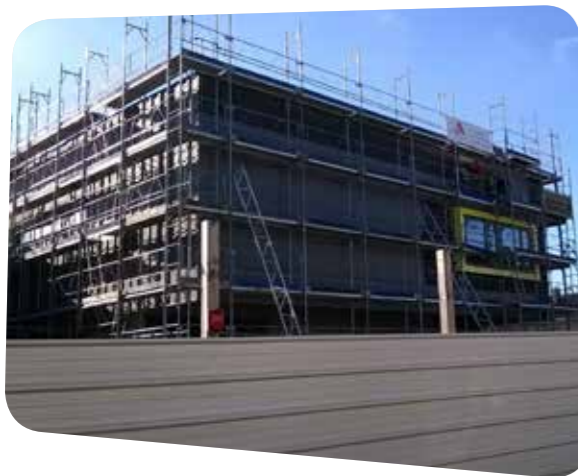
Collège Robert Schuman à Benfeld - Travaux d'extension en cours
