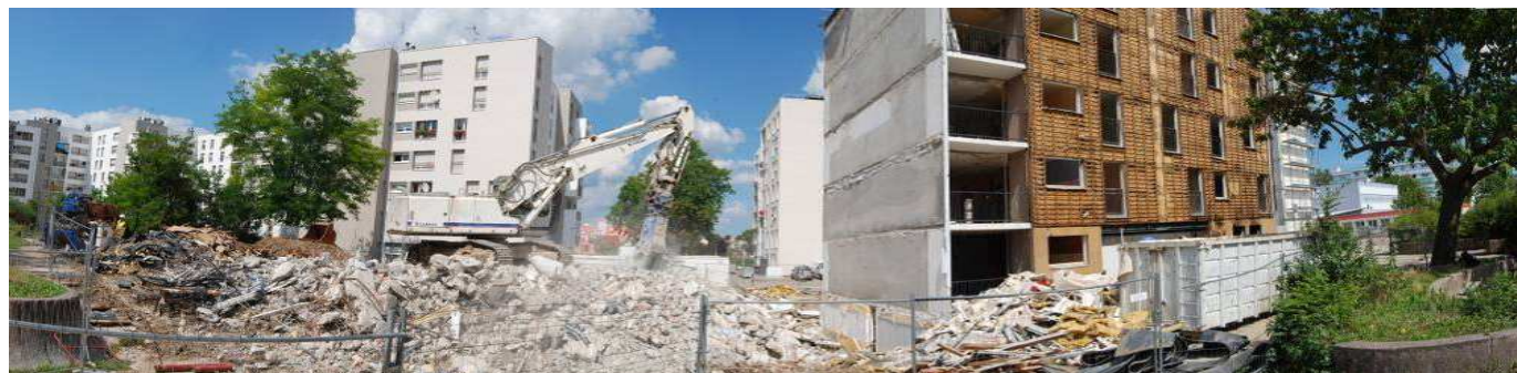
Démolition 19/20 place Byron Source: Eurométropole/ PRU/ B.de Carpentier
