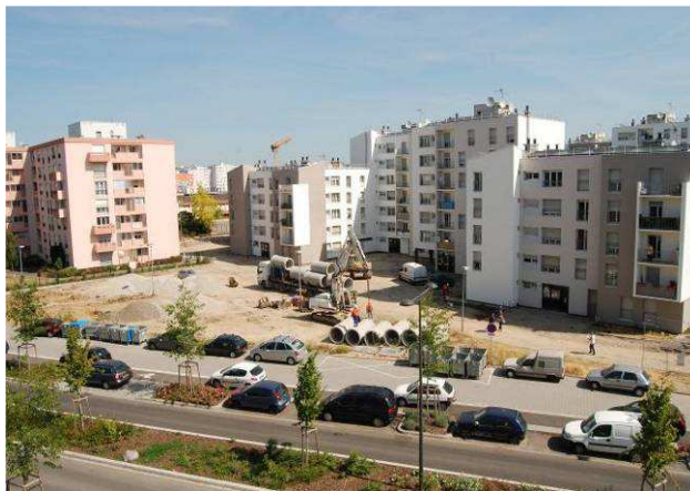
Chantier résidentialisation CUS Habitat avenue Racine Source: Eurométropole / B. de Carpentier
