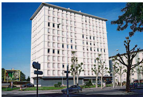
Situation avant intervention : Tour H, 5 rue de Franche-Comté avec ses commerces en rez-de-chaussée
