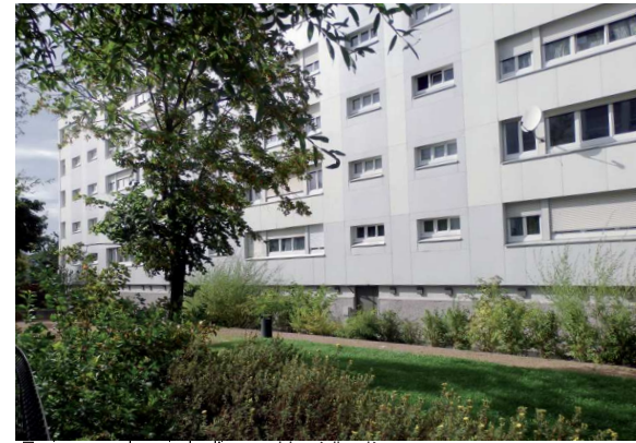
Traitement des pieds d'immeubles à l'arrière
