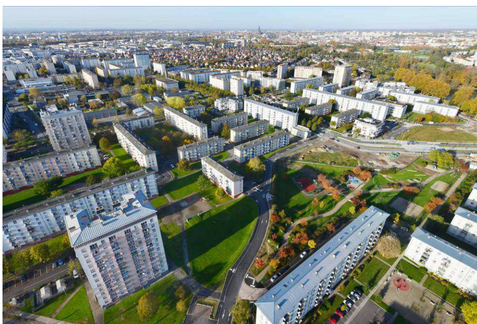
Vue aérienne 2014 : avenue de Normandie
