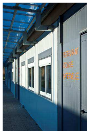
Nouvelle restauration scolaire de l'école Fischart (Ville de Strasbourg)
