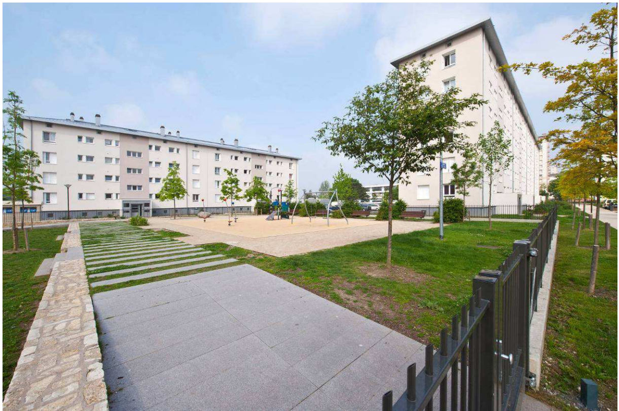
Réhabilitation – résidentialisation secteur Corse
