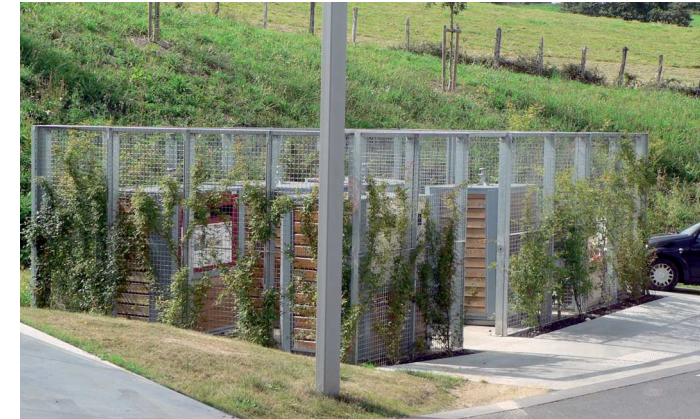
exemple de structure métallique accompagnée de végétation
