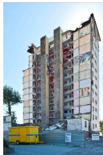
Démolition de la tour n°28 avenue de Normandie (CUS Habitat)
