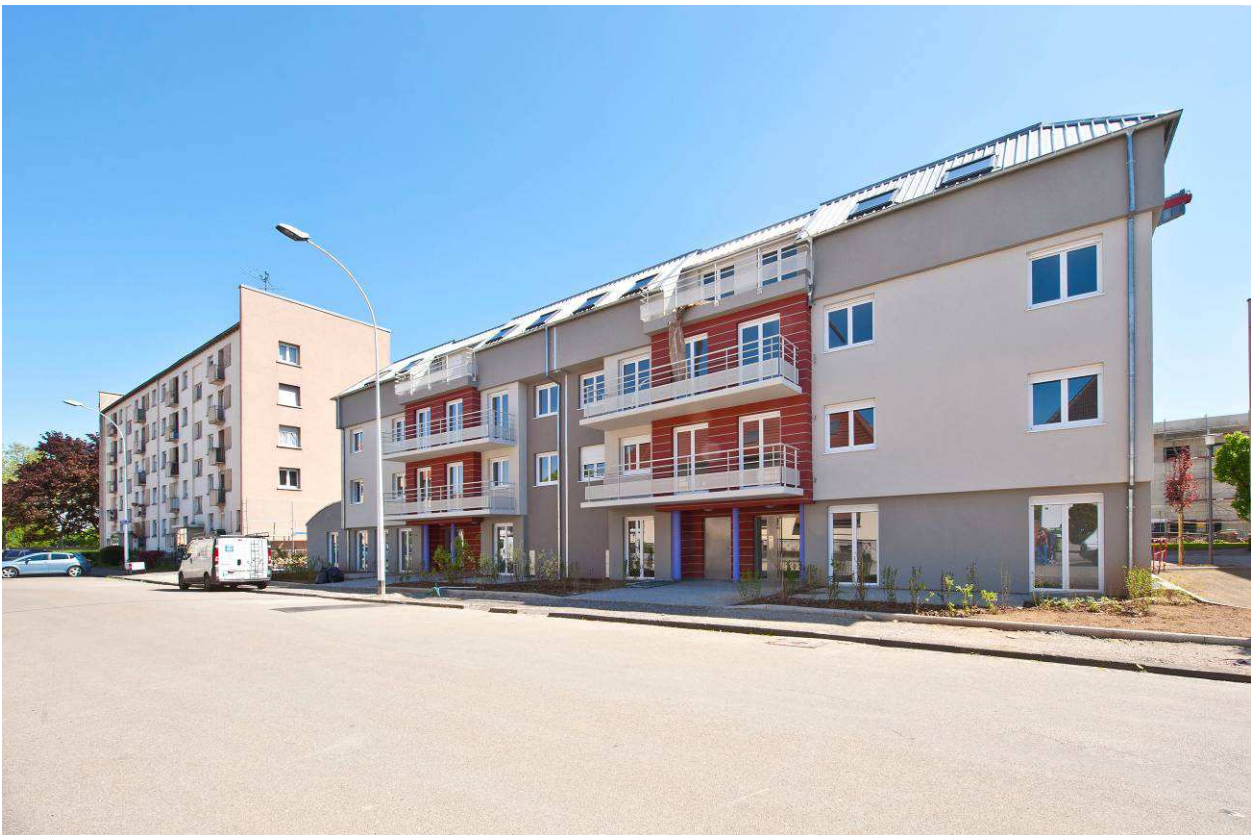
Construction rue de Klingenthal à Strasbourg (SIBAR)
