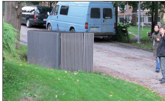
entourage bois autour bacs déchets
