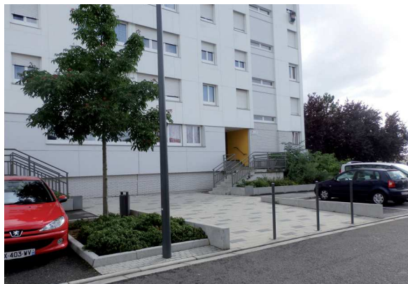
Traitement des parvis d'entrée
