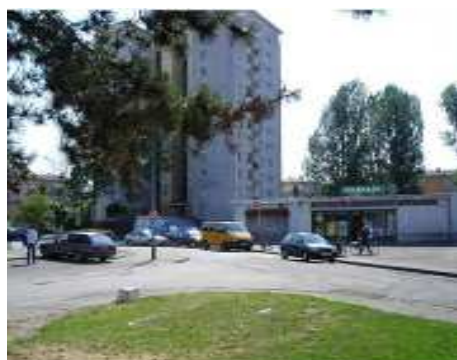
Situation avant intervention : Tour 28 avenue de Normandie et commerces
