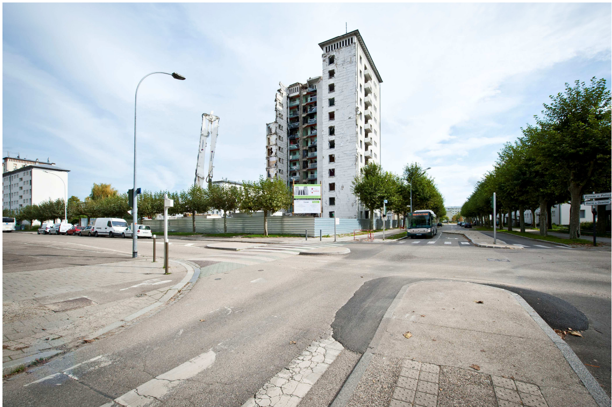
Démolition tour 33 avenue de Normandie (CUS Habitat)
