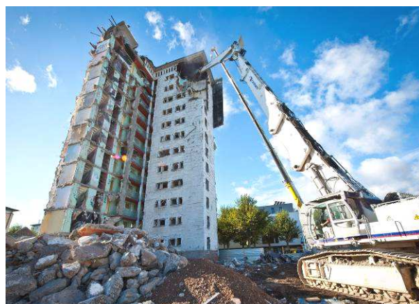
Démolition de la tour n°33 avenue de Normandie (CUS Habitat)
