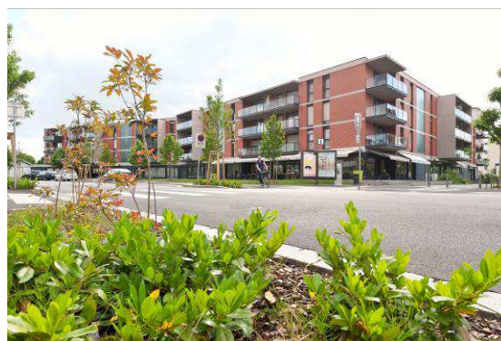
Situation après intervention : 74 logements et commerces – Terrain n°11 (SIBAR/Pierres et Territoires)
