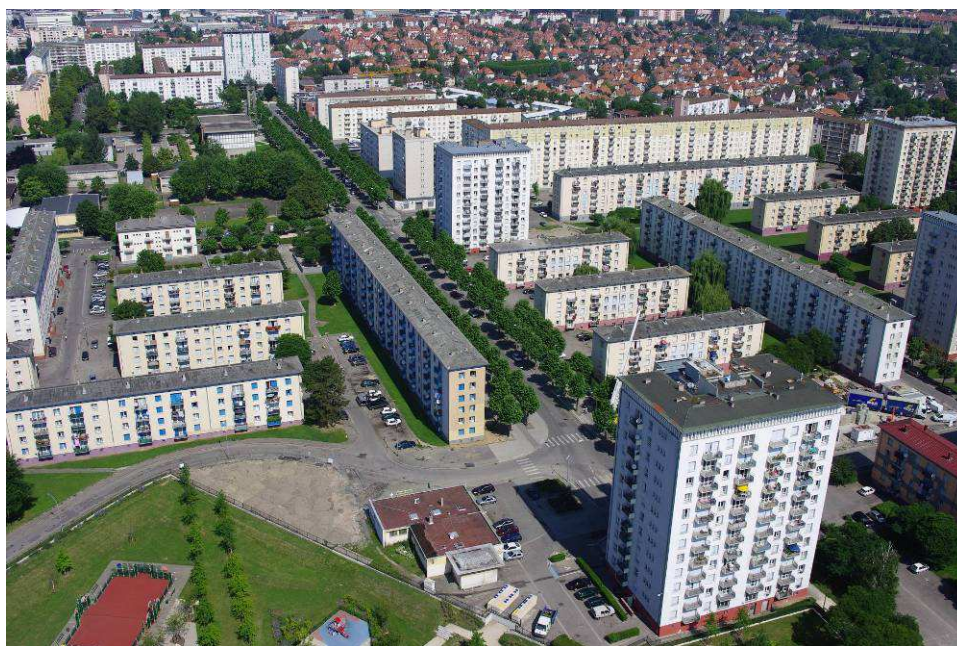
Vue aérienne 2008 : avenue de Normandie
