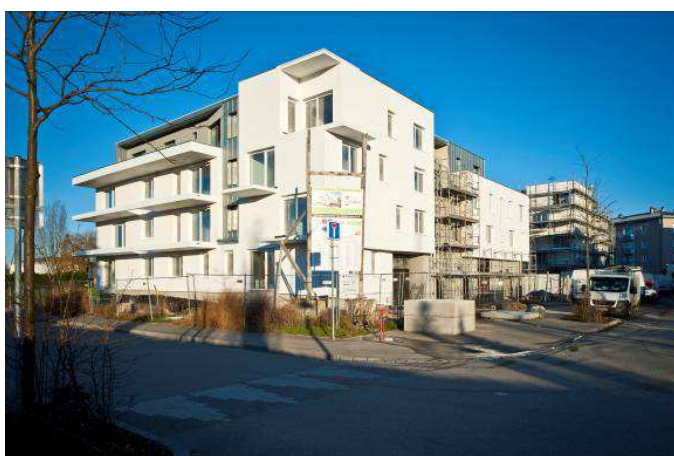
42 logements locatifs sociaux - Terrain n°17 (CUS Habitat)
