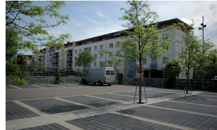
Pavés béton remplissage graviers - allée desserte en enrobé
