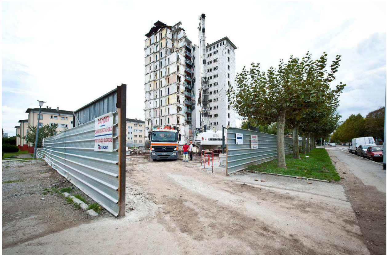
Démolition de la tour 33 avenue de Normandie
