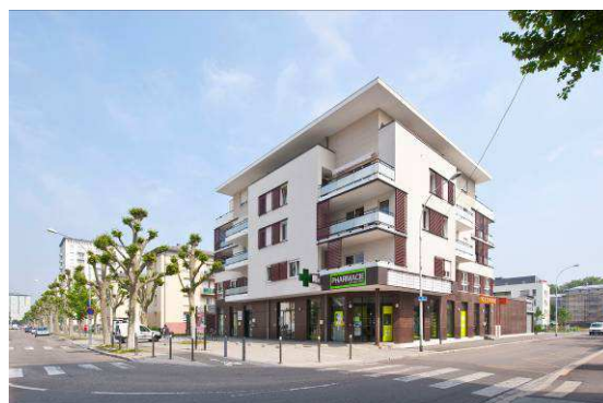
Situation après intervention : 13 logements locatifs sociaux et commerces – Terrain n°21 (CUS Habitat)
