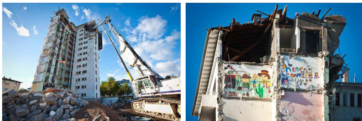
Démolition de la tour 33 avenue de Normandie (CUS Habitat)
